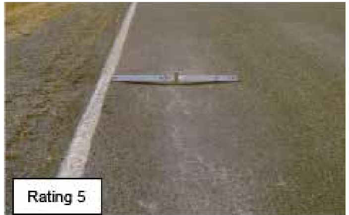
Extreme rutting (average depth > 30 mm.)
